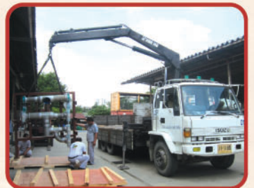
Forklift and unit crane rental ให้เช่ารถยกและรถบรรทุกติดเครน
